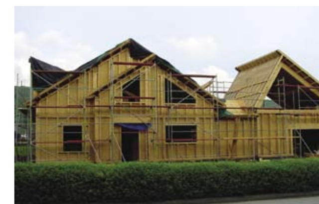
Construction en bois
