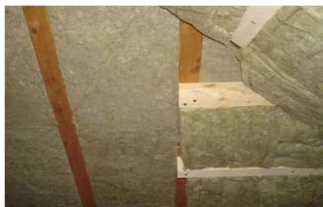
Isolation pans du toit
