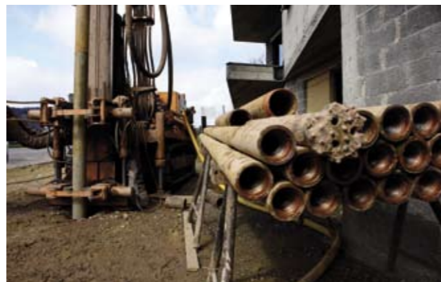
Forage vertical pour pompe à chaleur
